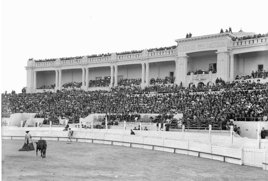
10. Les gradins du Stade avec les trois catégories de places : tribunes couvertes, gradins et toiture-terrasse, 1913, APN
