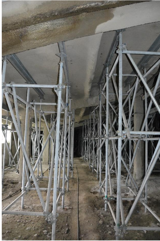
15. Échafaudages sous les gradins du Stade qui sont amenés à disparaître
