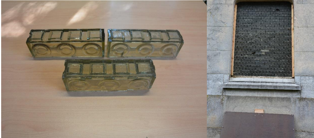
12. Briques de verre provenant du Stade des Jeux 13. Baie composée de briques de verre côté Théâtre
