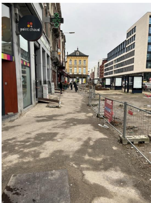
Exemple de coffrage du Boulevard Mélot rendant l'accessibilité plus aisée
